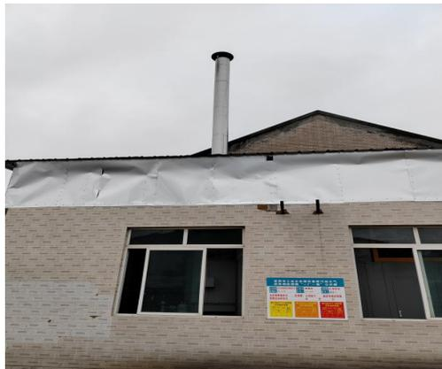
图 3.8 锅炉房建筑隔声
