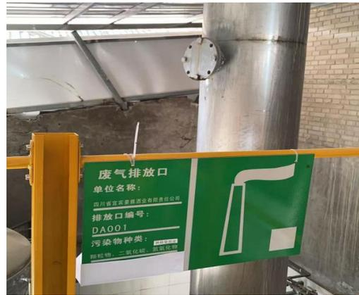
图 3-2 锅炉排气筒（DA001）及监测孔
