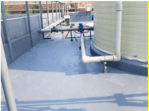
罐区环氧地坪
