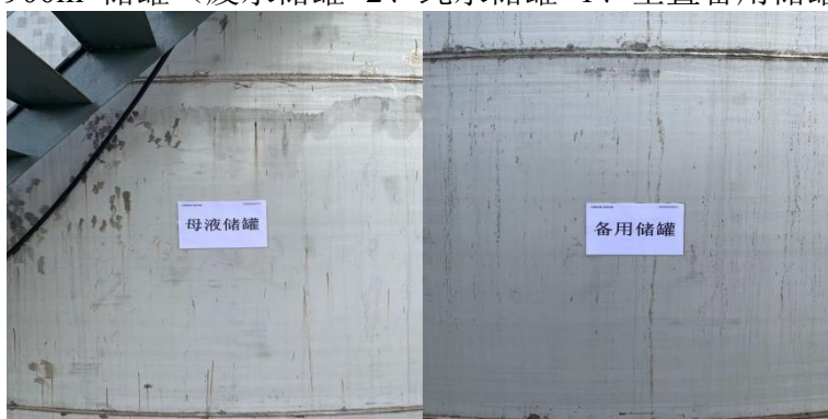
4 个 900m 3 储罐（废水储罐×2、纯水储罐×1、空置备用储罐×1）
