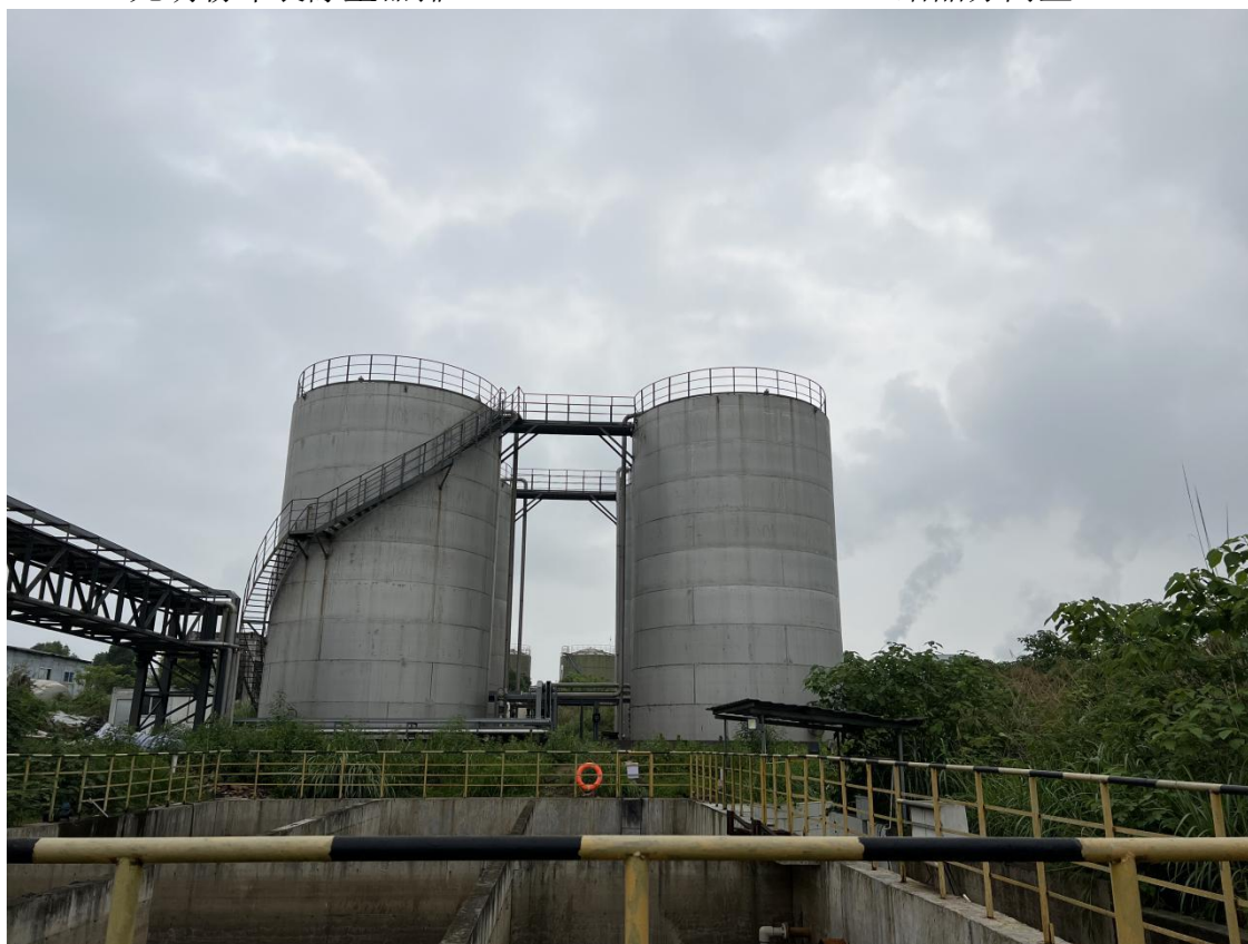
4 个 900m 3 储罐（废水储罐×2、纯水储罐×1、空置备用储罐×1）
