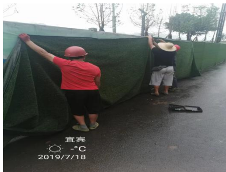
现场围挡施工情况
